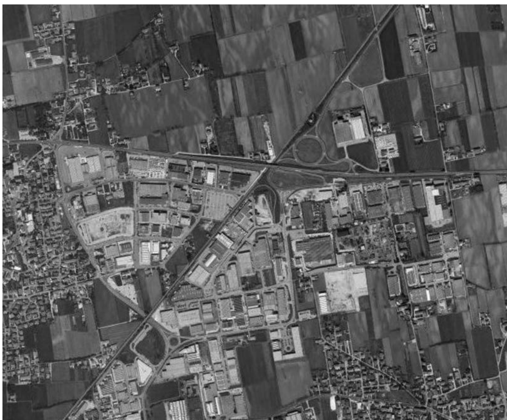
Figura 7. El área comercial-industrial de Castelfranco Veneto a lo largo de la SR 53 (carretera regional). Fuente: Región del Véneto (2003)
