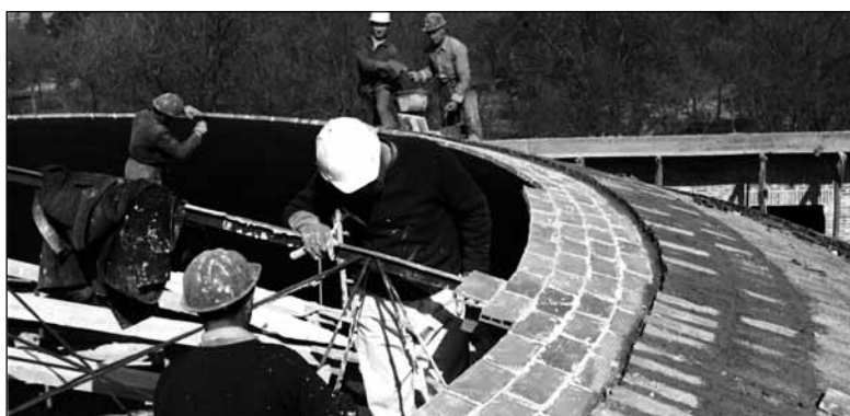
Parroquia de Santa María Madre de la Iglesia en Carabanchel (Madrid) (1966-1969): Moya, con técnicos del Instituto Torroja, supervisando las obras de la cúpula; detalles del proceso constructivo de la misma. [Colección particular]
