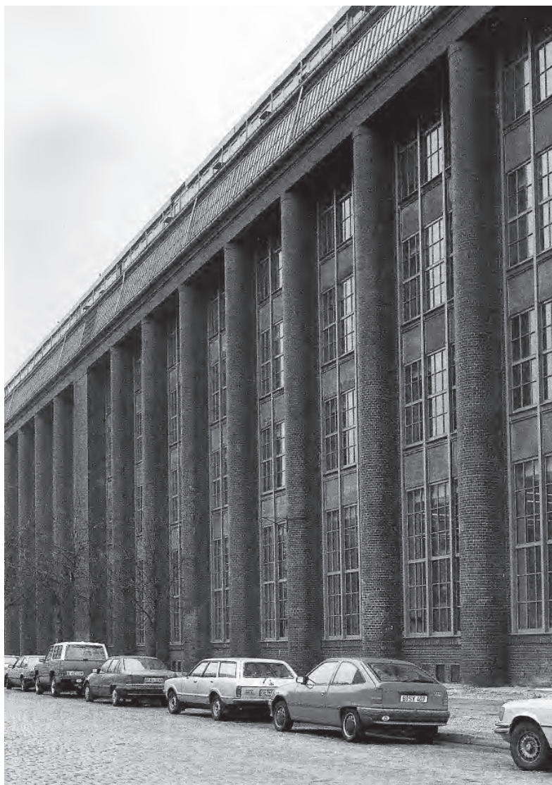
3.8. AEG. Fábrica de pequeños motores. Vista parcial de la fachada a la Voltastrasse. Berlín (1910-1913)
