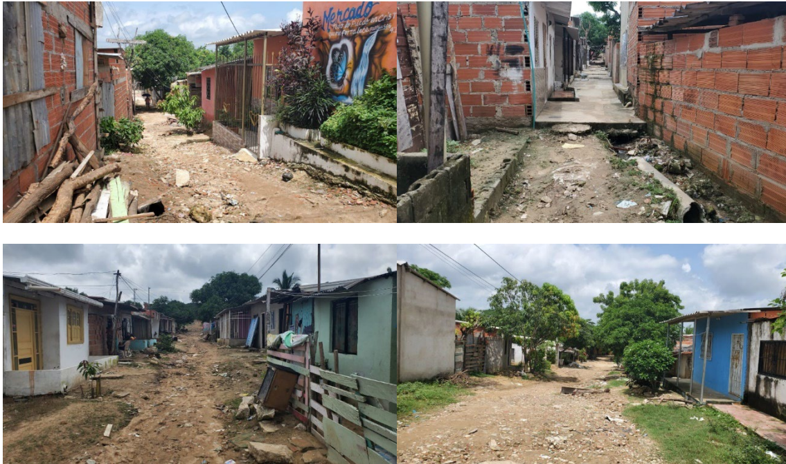
Figura 4. Perfiles y cañones urbanos en el asentamiento informal: V1, V2, V3 y V4.
