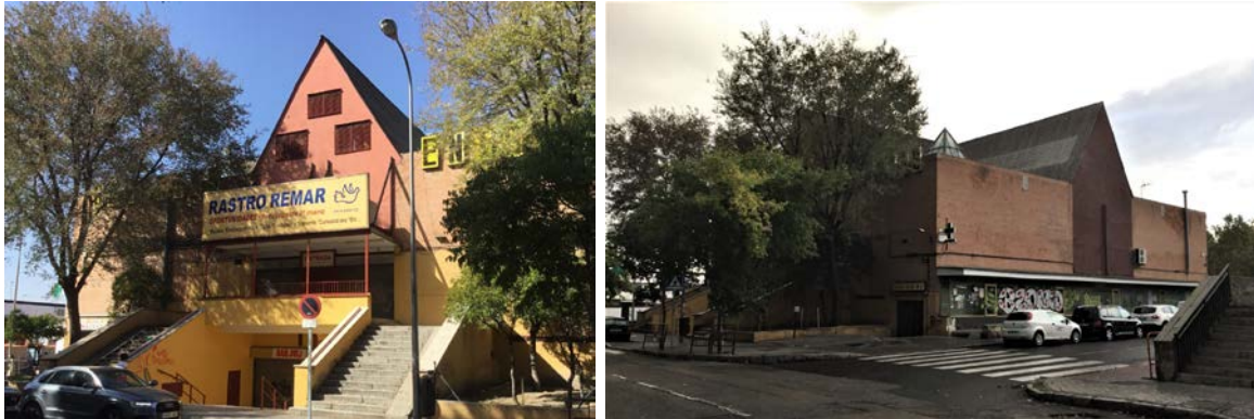
Figura 44 (izda.). Estado actual del Supermercado de la 2ª Fase. Las vidrieras han sido tapiadas, hay carteles, marquesinas y estructuras metálicas añadidas, y los locales se encuentran cerrados.
