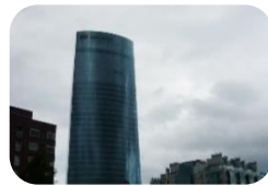
Torre Iberdrola- Cesar Pelli- 2012
