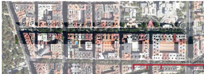
Figura 3. Imagen aérea caso 3 (Fuente: Google Earth. Elaboración propia. 2015).
