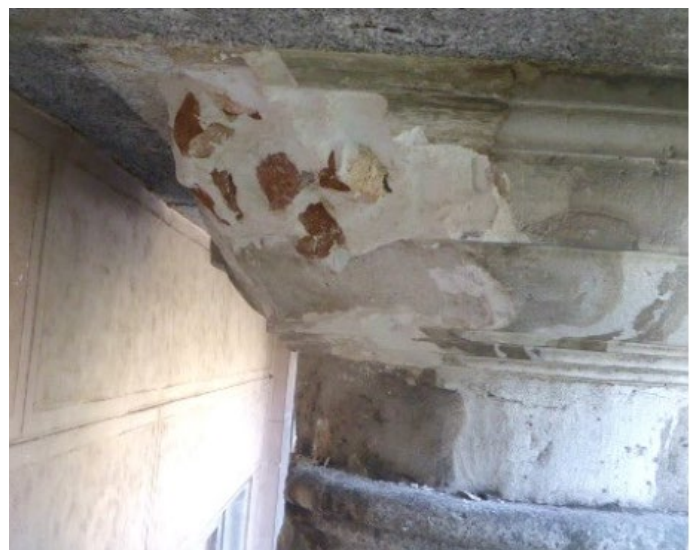
FIG 13.4. Reparación defectuosa.
