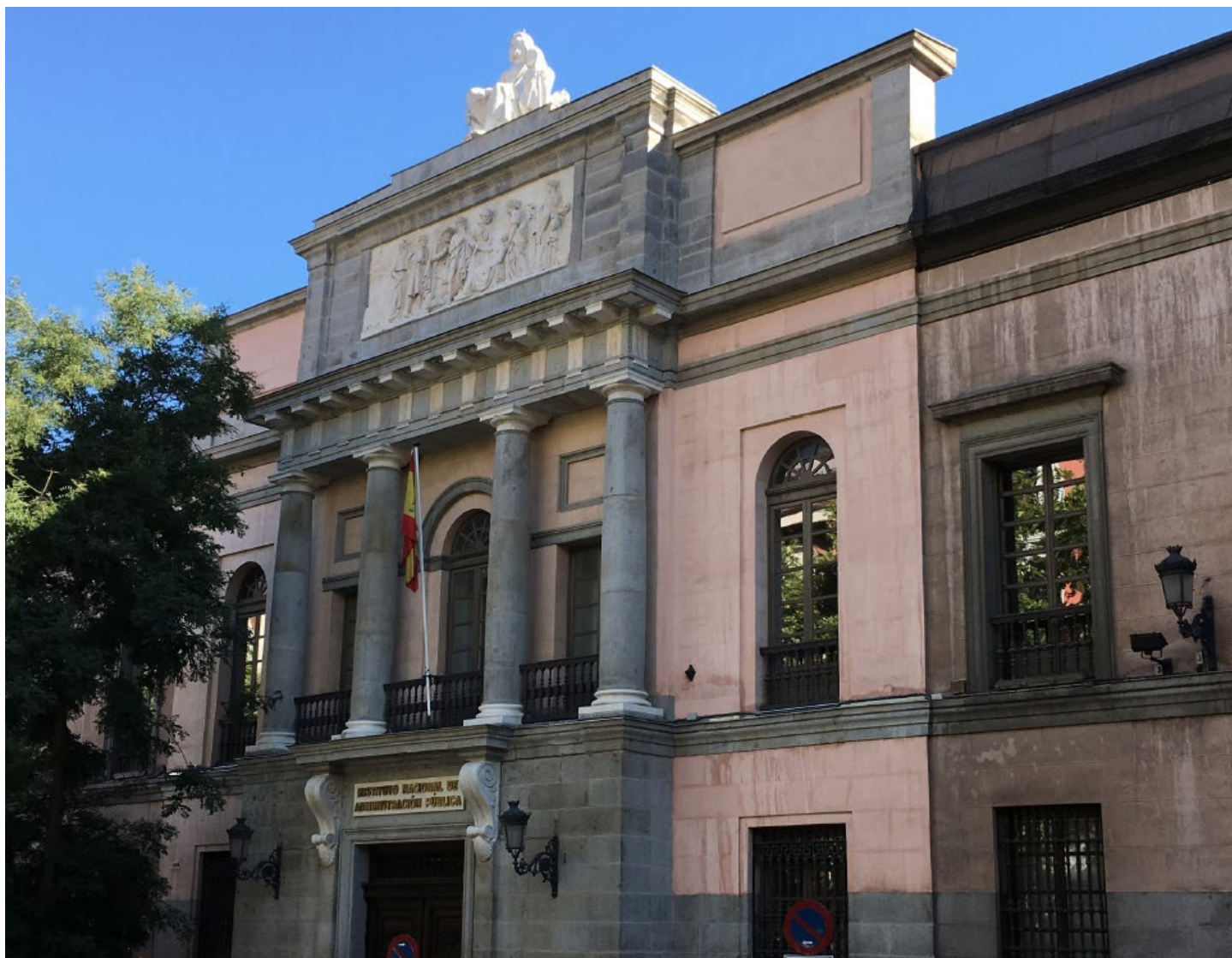
FIG 21. Portada después de la restauración (agosto de 2017). Se observa la diferencia entre el revoco de la portada tras la limpieza y el revoco del resto de fachada. Se consensuó con la Propiedad aplicar una imprimación al silicato homogeneizadora tras la limpieza del resto de la fachada prevista en breve. De esta forma se evitaría la diferencia entre tonalidad de diferentes intervenciones.
