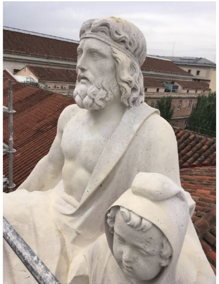
FIG 17.1. Escultura antes de la restauración y después de la reposición con mortero específico. 2. Puede verse un nuevo manchado de excrementos de ave en la cabeza antes de terminar las obras.
