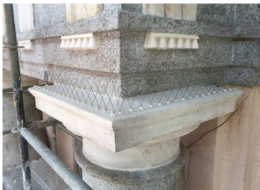
FIG 18.2. Capitel con formación de pendiente a 3 aguas a base de mortero hidrófugo. Acabado con sellante e impermeabilizante.
