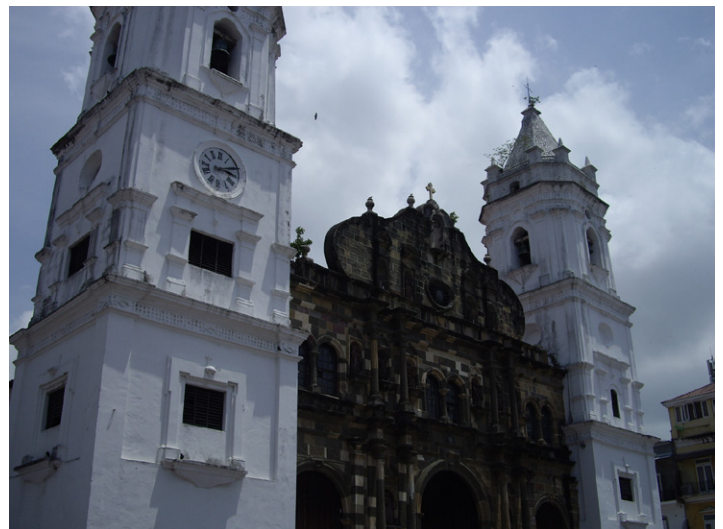
14. Torres de mampostería revestida (2015).
