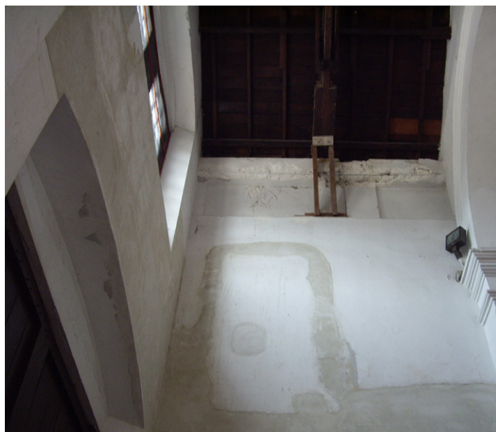
8. Situación de puerta en muro lateral de torre en el tramo de los pies.
