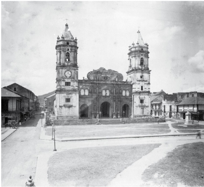
3. Desprendimiento del remate del frontón (fotografía C. Endara, 1882).
