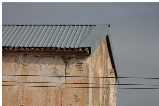
18. Cubierta provisional metálica
