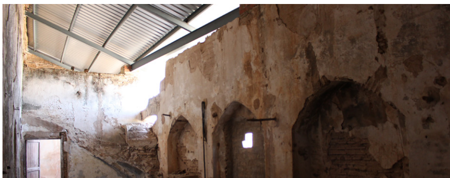
19. Cubierta provisional vista desde el interior.
