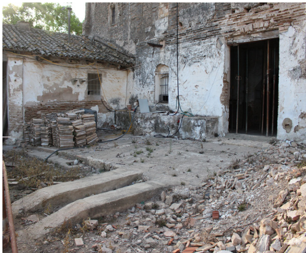
31. Pozo en fachada norte del volumen principal. 20
