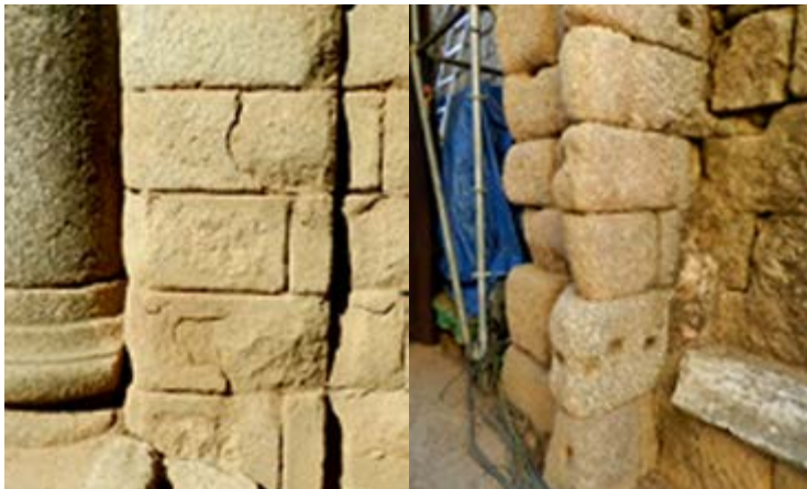
17a. 17b. Vano de acceso a las galerías en la versura oriental, deplacación frontal de los sillares de granito y erosión de las zonas más expuestas.
