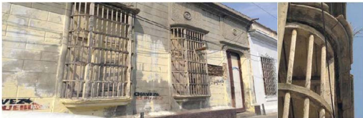
16. Ventanas de fachada tradicional.
