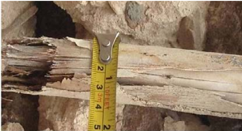
8 a. Sección de caña brava de una vivienda (Pineda, 2012).
