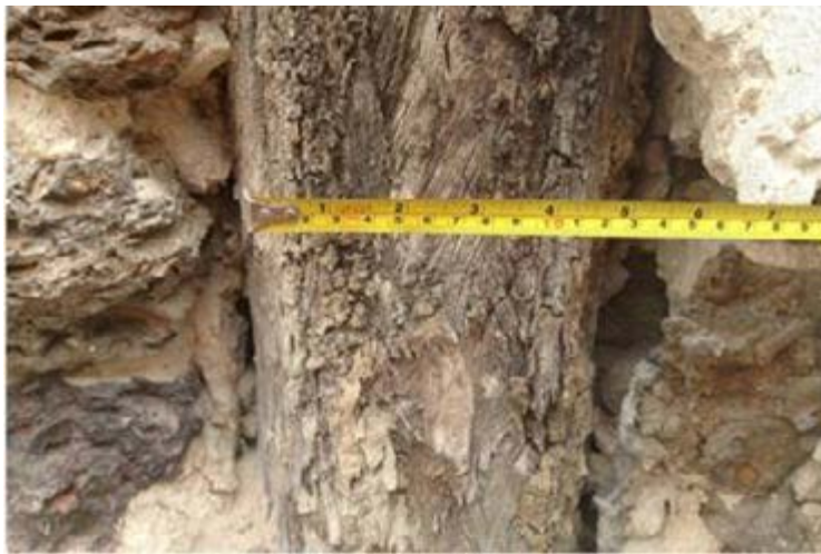
14. Horcón de araguaney de entramado de muro.
