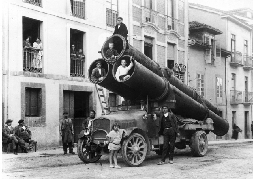
Figura 11. Transporte de tubería a su paso por la localidad de Grado. (F. Archivo HC) [6] Transport des conduites à son pas par la localité de Grado. (F. Archives HC) [6]
