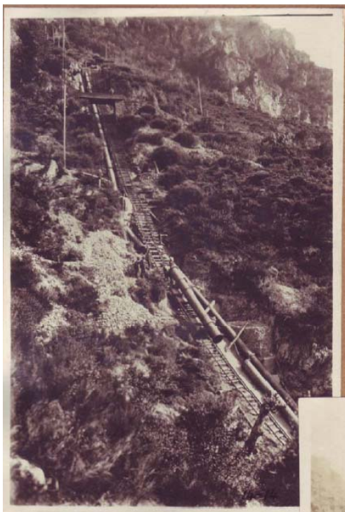
Fig. 12. Montaje de la tubería forzada. (F. Saltos de agua de Somiedo. Memoria D.). Montage des conduites forcées. (F. Chutes d'eau de Somiedo. Rapport D.).
