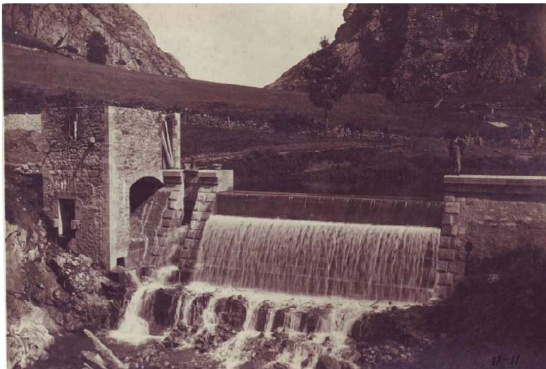
Figura 5. Presa de El Valle. (F. Saltos de agua de Somiedo. Memoria D.) Barrage de El Valle. (F. Chutes d'eau de Somiedo. Rapport D.)
