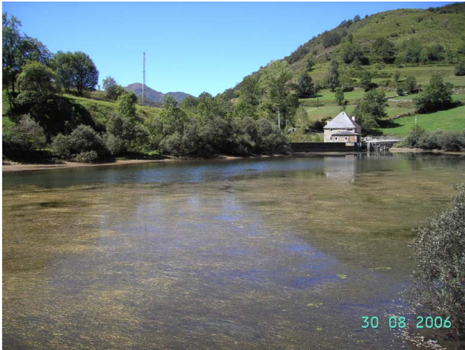
Fig. 3. Embalse de Valle. (F. A. Martin). Réservoir de Valle. (F. A. Martin)
