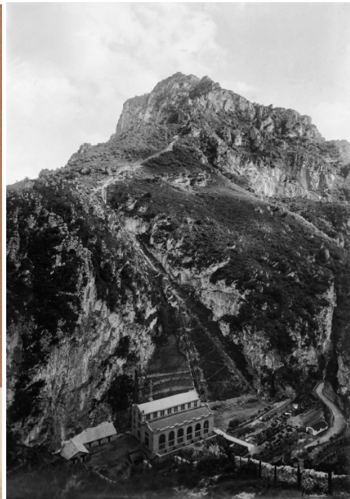
Fig. 12. Montaje de la tubería forzada. (F. Saltos de agua de Somiedo. Memoria D.). Montage des conduites forcées. (F. Chutes d'eau de Somiedo. Rapport D.).
