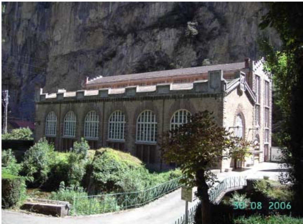
Figura 23. Estado actual del edificio de la Central (F. A. Martín). État actuel du bâtiment de la Centrale (F. A. Martín)
