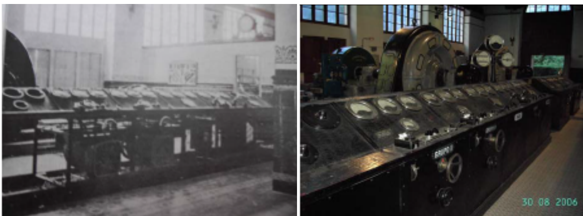
Fig. 32. Ida: Cuadro de mandos tipo pupitre. Año 1917. Dcha: Vista actual del cuadro de mandos, lógicamente sin uso. Año 2006. (a) (F. Saltos de agua de Somiedo. Memoria D.) (b) (F. A. Martín).
