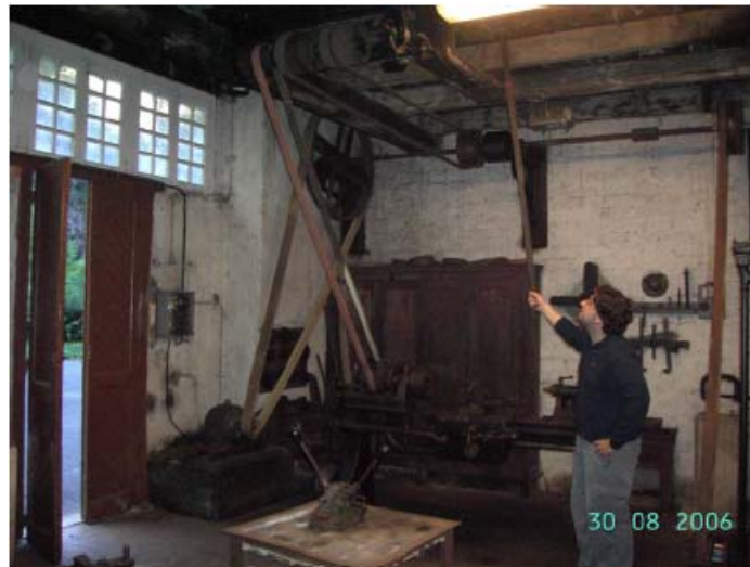
Fig. 33. Taller de reparaciones y mantenimiento. Obsérvese la transmisión con embrague. (F. A. Martín). Atelier de réparations et entretien. Voir la commande par embrayage. (F. A. Martín)
