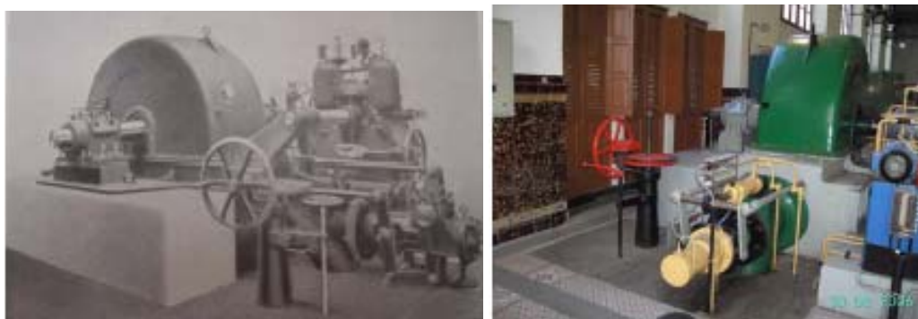
Fig. 28. Izda: Turbina Pelton con los sistemas de regulación. Año 1917. Dcha: Turbina Pelton con nuevos sistemas de regulación electrónico-hidráulico. Obsérvese que se mantiene la válvula vertical, con volante rojo. Año 2006. (a) (F. Saltos de agua de Somiedo. Memoria D.) (b) (F. A. Martín). Gauche: Turbine Pelton avec les systèmes de régulation. Année 1917. Droite: Turbine Pelton avec nouveaux systèmes de régulation électronique-hydraulique. Voire que la vanne verticale est maintenue, avec volant rouge. Année 2006. (a) (F. Chutes d'eau de Somiedo. Rapport D.) (b) (F. A. Martín).
