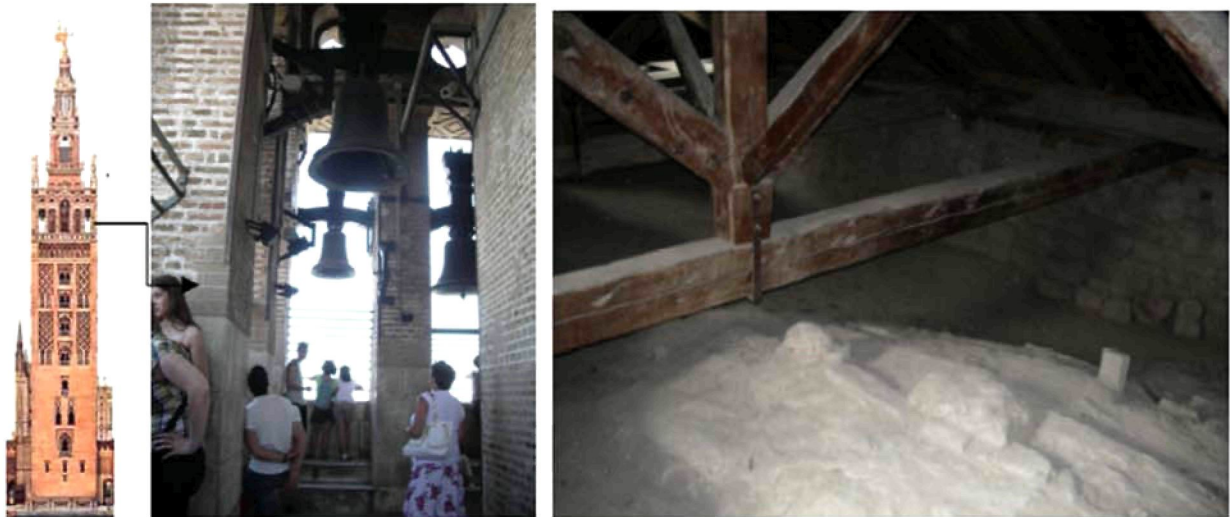
Fig. 17. a) Torre de la Giralda; 17. b) Interior del campanario de la torre; 17. c) Bajo cubierta de la de Palencia / a) Giralda Tower; b) bell tower interiors; c) Palencia Cathedral soffit
