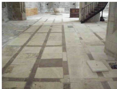
Pavimento de la iglesia de San Nicolás de Bari, en Burgos, recientemente restaurado. Los suelos de este tipo no sólo contienen valores testimoniales, sino que, además, cumplen con las normas actuales con una sencilla reparación / Flooring on San Nicolás de Bari Church at Burgos, recently restored. This type of floor not only has testimonial value, but also meets current requirements thanks to a simple repair
