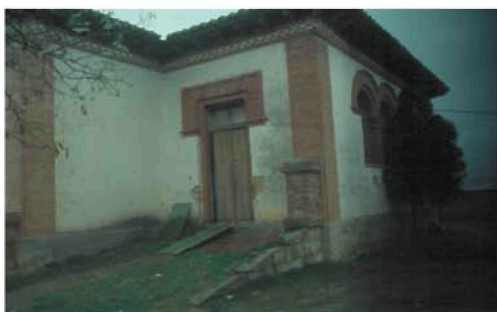
Escuela rural, obra de Joaquín Muro, en Castromonte. Obra de 1934 que, junto con las demás realizaciones del equipo de Antonio Flores cubrió todas las necesidades del aula, incluyendo la de la accesibilidad / Rural school designed by Joaquín Muro in Castromonte. Built in 1934, it met all classroom needs, including accessibility, a common feature in the structures erected by the Antonio Flores team
