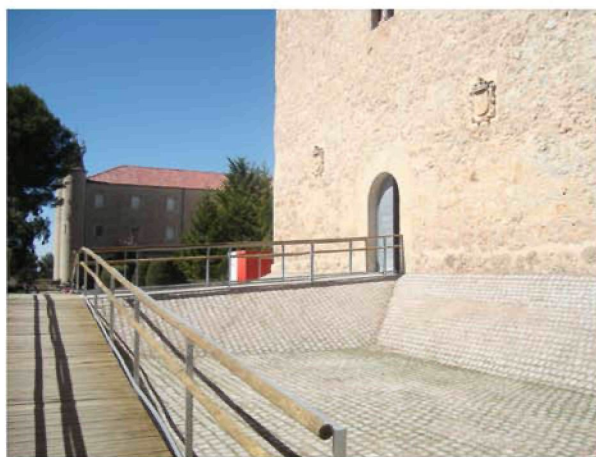
Adecuación del acceso al torreón de los Guzmanes, en el Monasterio de Caleruega, de Alba y Miranda, rehabilitado como espacio expositivo / Adaptation of the entrance to the Guzmanes tower at Caleruega Monastery, by Alba and Miranda, rehabilitated as an exhibition venue
