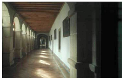
Pasillo, en este caso El Escorial, de un monasterio. Amplitud, luminosidad, suelo no deslizante, texturas diferenciadas y ausencia de desniveles / A monastery corridor, here in El Escorial. Amplitude, brightness, non-slip floor, different textures and all on a single storey
