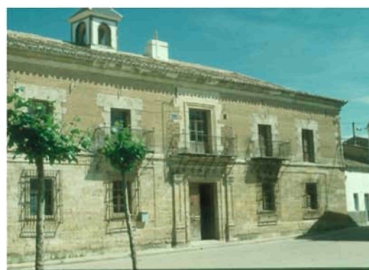
Uno de tantos consistorios de Castilla. Morales de Toro. Edificios civiles diáfanos y de sencillos esquemas de distribución, con mínimos obstáculos en los accesos / One of numerous town halls in Castile. Morales de Toro. Open plan civil buildings with simple interior layouts and scantily any obstacles at the entrance
