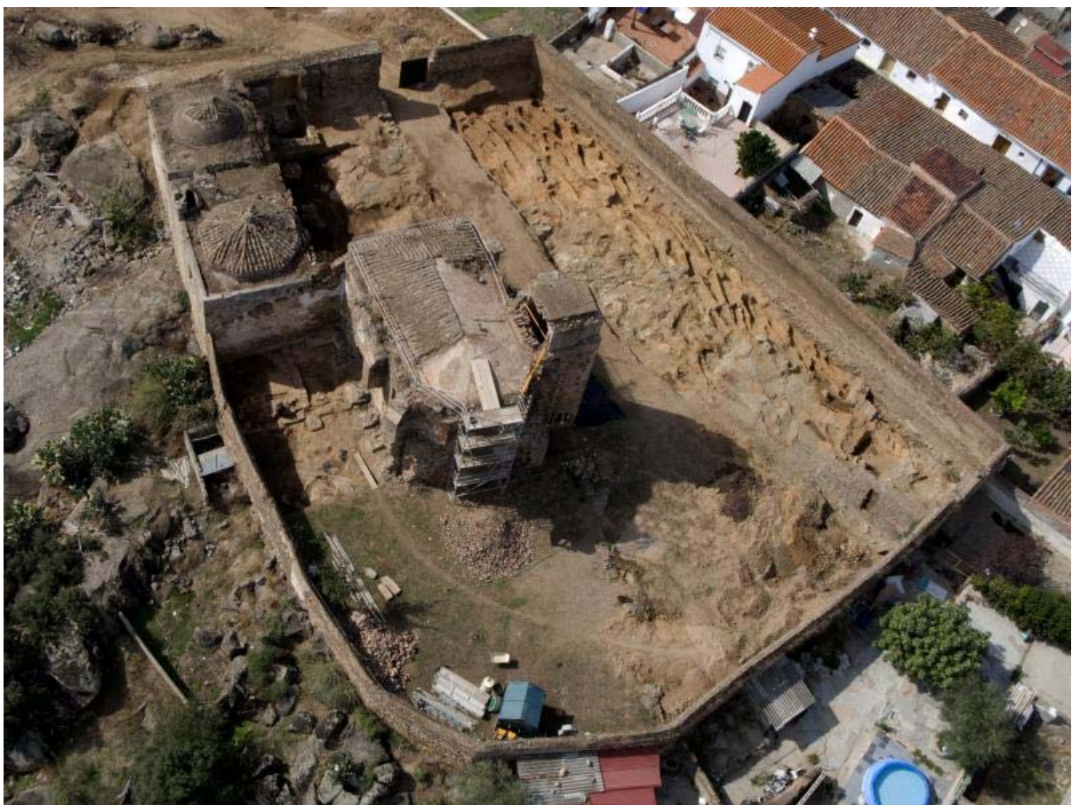
Fig. 4. Conjunto de San Juan Bautista durante los trabajos de restauración en 2010. L'ensemble de San Juan Bautista durant les travaux de restauration en 2010 (photographie Arqveocheck).
