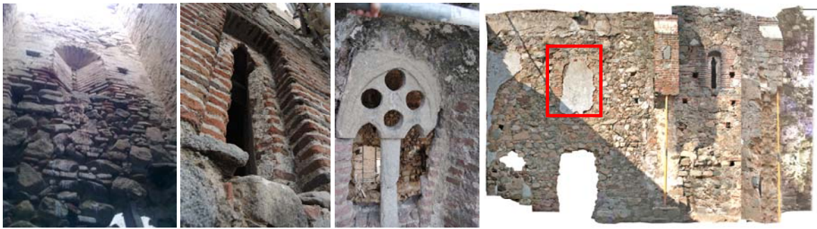
Figura 7. Aspecto exterior: a) Ventana aspillerada Norte; b) ventana Sur; c) tracería de la nave principal Norte; d) ventana Sur clausurada (antes de la restauración, ortofotografía Arqveocheck, 2010).
