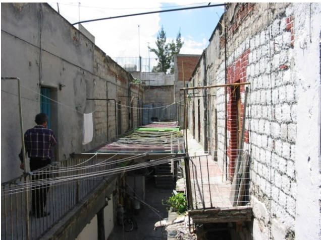
Fig. 13. Interior del inmueble. Estado anterior. Building interior. Previous state.
