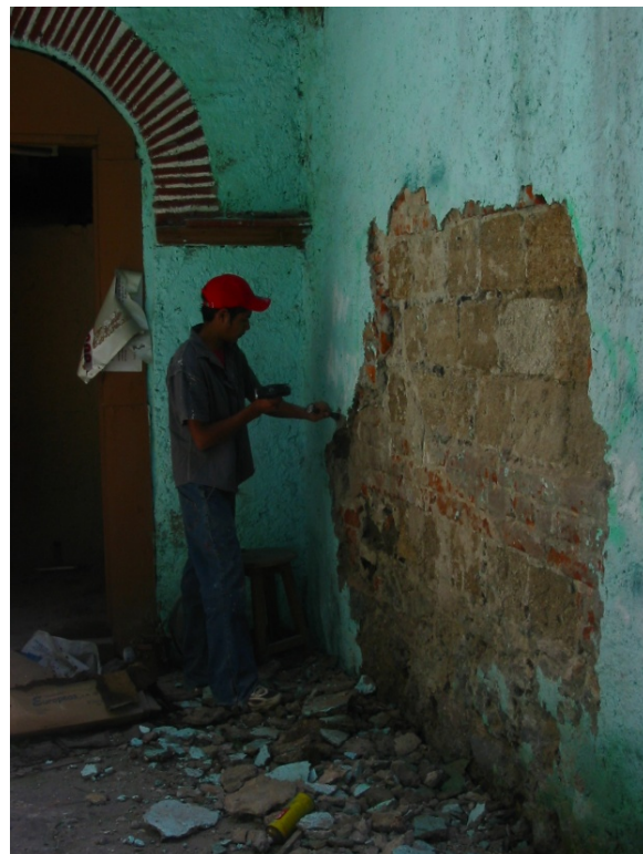
Fig. 8. Eliminación del enlucido de muro limosnero Elimination of the wall plastering " limosnero "
