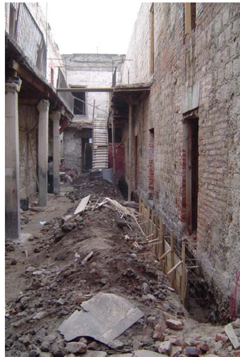
Fig. 6. Refuerzo de la cimentación. Foundation reinforcement.
