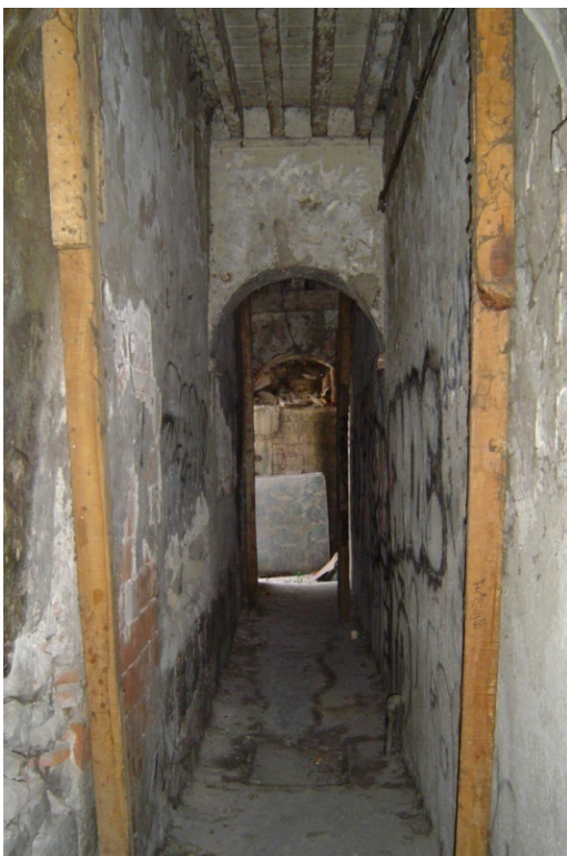
Fig. 7. Pasillo interior. Inner corridor.
