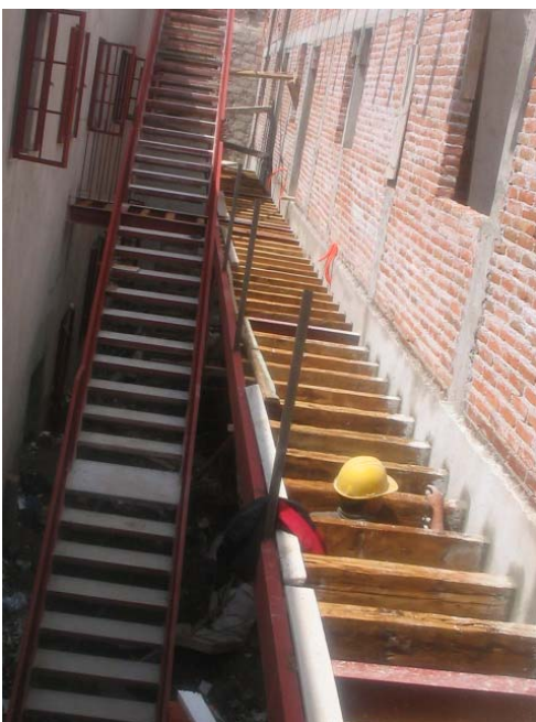
Figs.11 y 12. Muros nuevos antes de la aplicación de los aplanados. Escaleras y pasillo balcón de acuerdo al proyecto (dcha). New walls before the application of the rendering ones. Stairs and corridor balcony according to the project (right).
