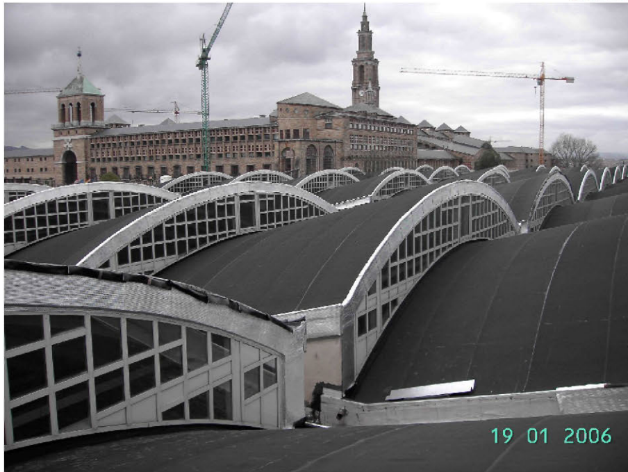
Figura 11. Cubiertas en diente de sierra constituidas por bóvedas tabicadas. Obsérvese el contraste con la parte “noble” de la ciudad.
