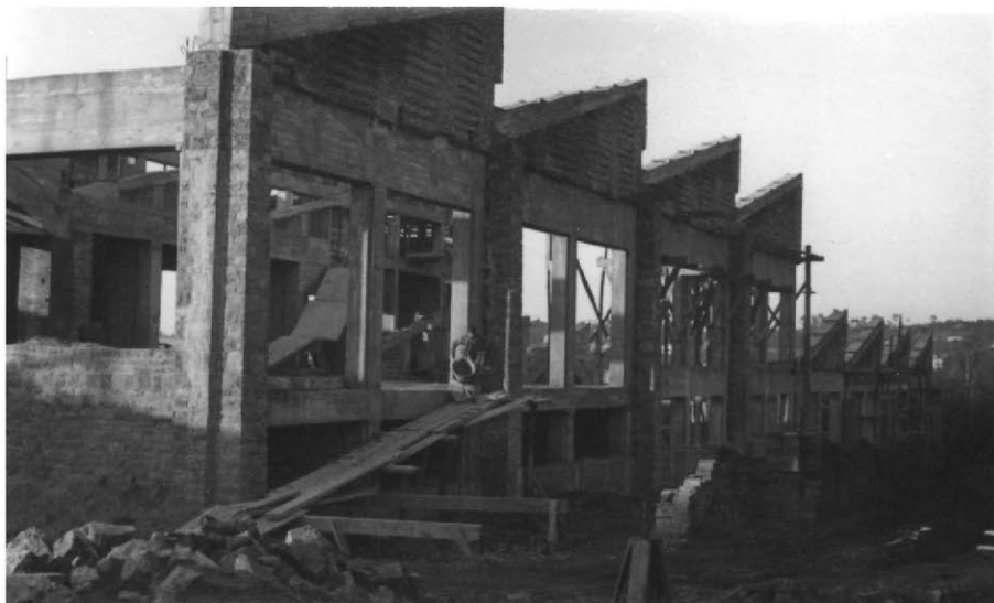
Figura 7. Construcción de los dientes de sierra. Figure 7. Building the saw-toothed bays.
