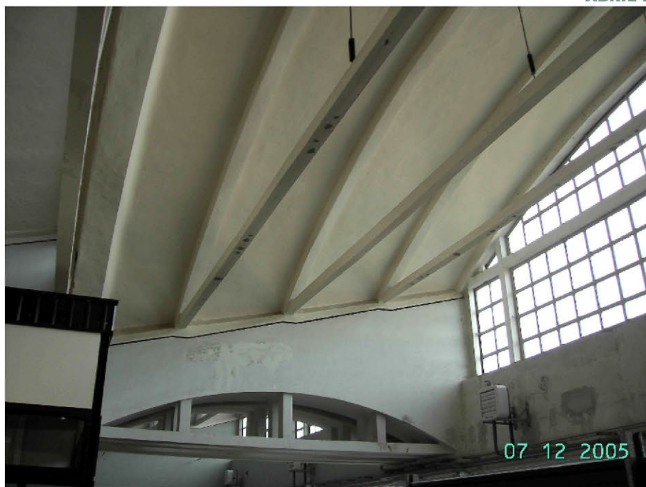
Figura 8. Bóveda arcos y tirantes. Figure 8. Bowstring vault.
