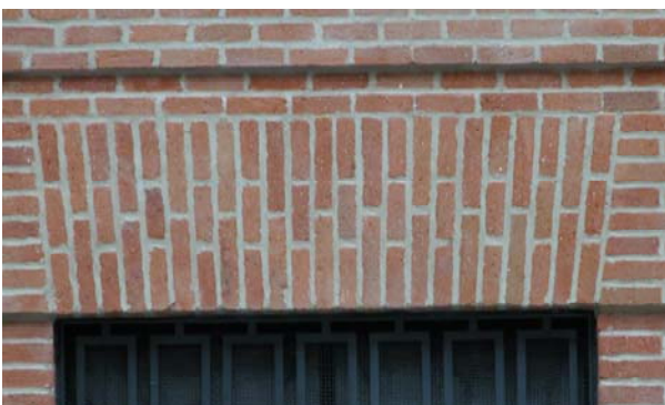
Figura 3: Dispensario de la Cruz Roja: Dintel de 1½ pies repartido entre ocho hiladas (ladrillo 27x13x4).
