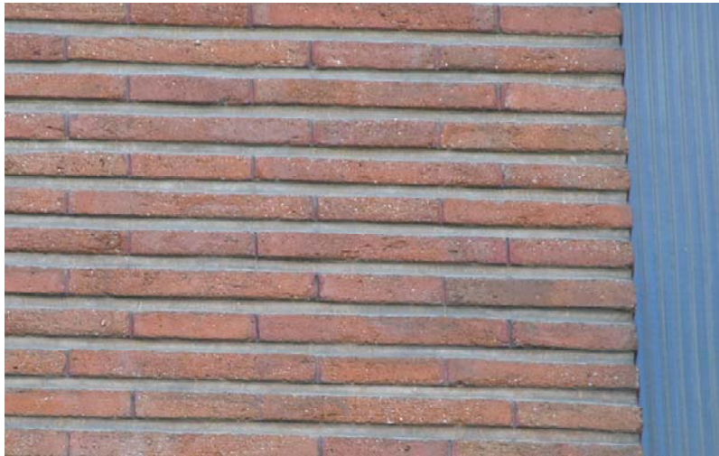
Fig. 5: Imprenta Municipal: la utilización de un ladrillo de 27x13,5 con llaga a hueso obliga a elegir un aparejo como el gótico.
