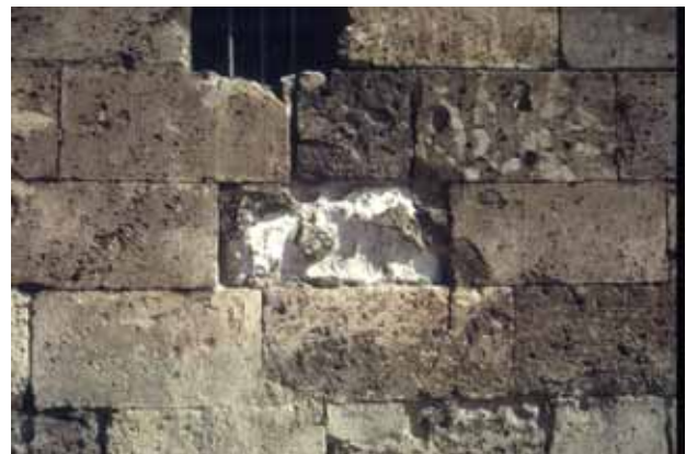
Figura 2. Sillares aparentemente del mismo tipo de piedra (dolomía blanca) y expuestos al mismo ambiente con notables diferencias de alteración, en la Catedral de Palma de Mallorca.
