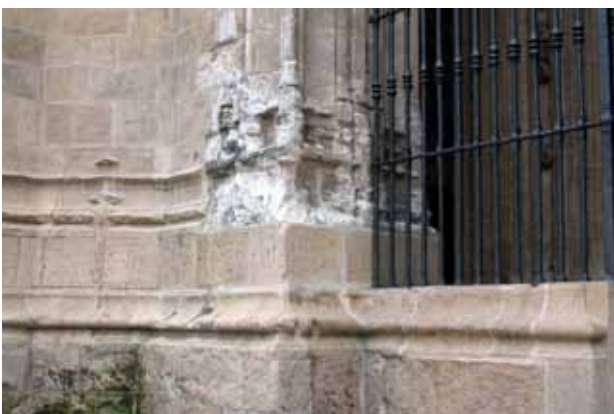
Figura 1. Acusadas diferencias de alteración entre dos tipos de piedra (caliza amarilla y dolomía blanca) situadas en ambiente similar, en la Catedral de Oviedo.
