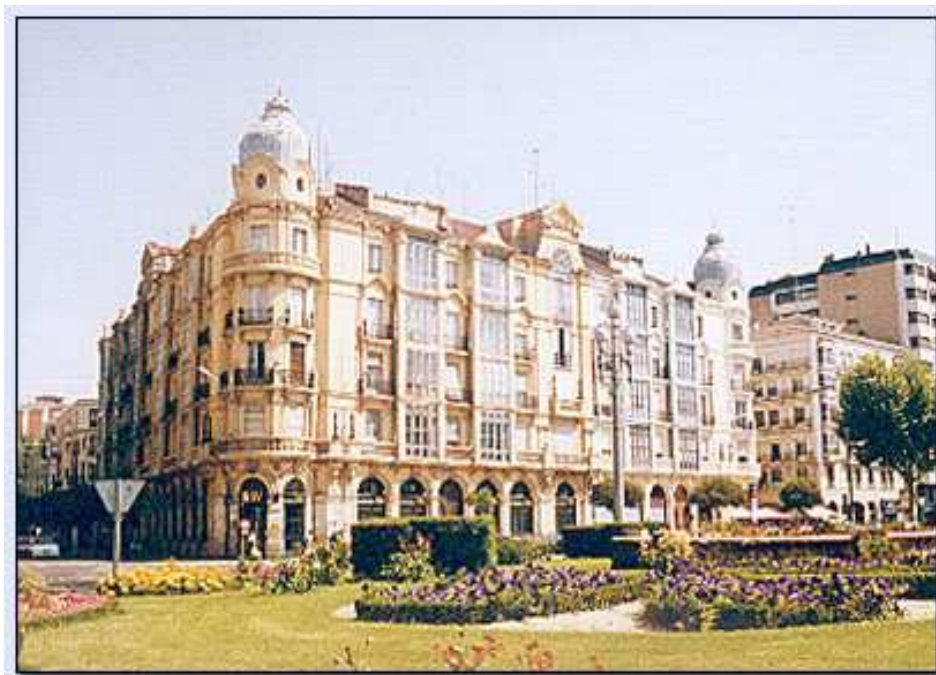
Figura 1a. Edificio Mantilla. Mantilla Building
