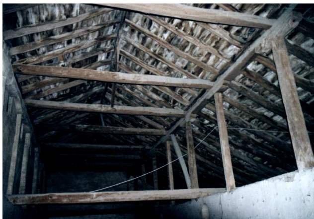
Figura 9. Interior de una cubierta mixta de tres crujiás. Interior of a mixed roof of three bays.
