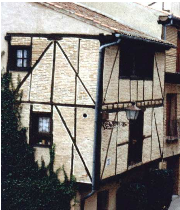
Figura 1. Edificio entramado en Segovia Timber framed building in Segovia
