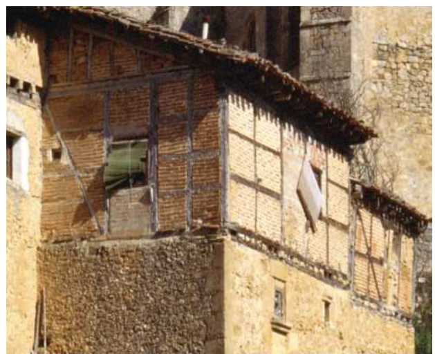
Figura 2. Edificio entramado en Calatañazor (Soria) Timber framed building in Calatañazor (Soria)
