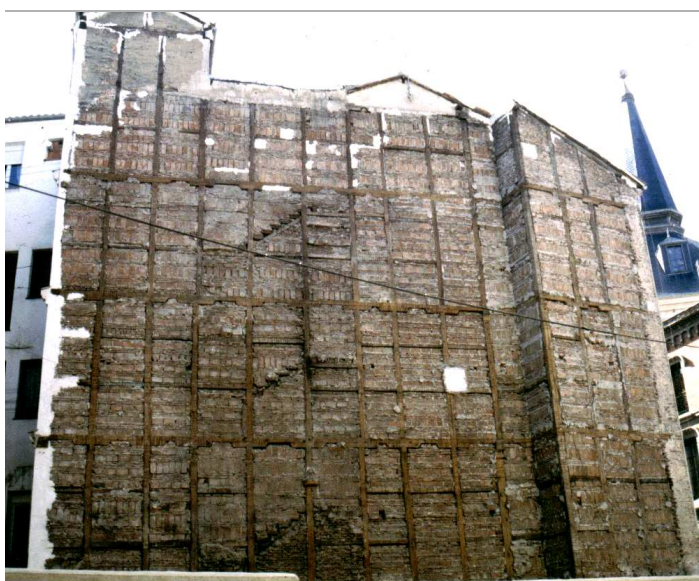
Figura 3. Muro entramado en un edificio madrileño.
