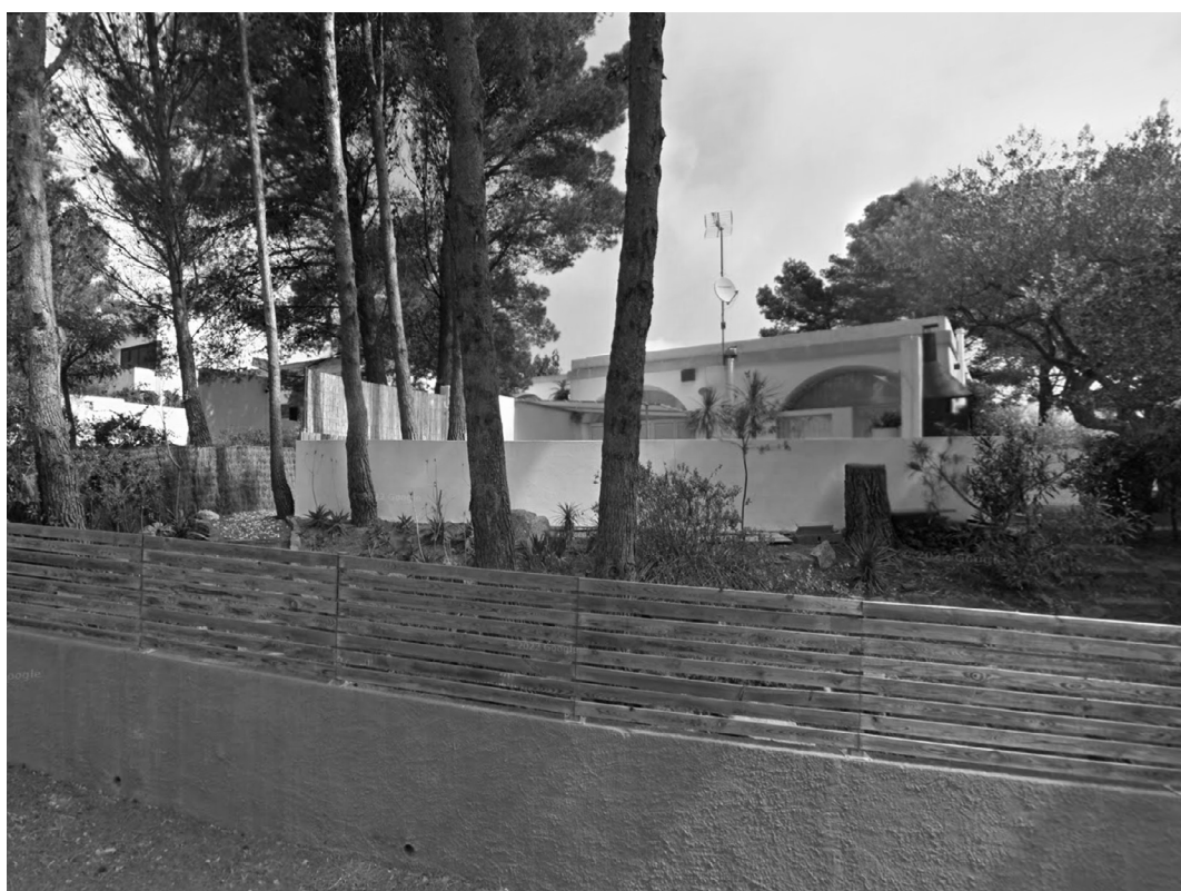
Fig. 03. Estado actual de los bungalós, transformados respecto a su configuración original (julio 2015)
