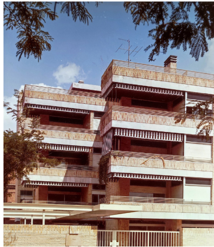
Fig. 09. Mariano García Benito. Viviendas en Cinca. Planta tipo y vista frontal, Madrid 1967.
