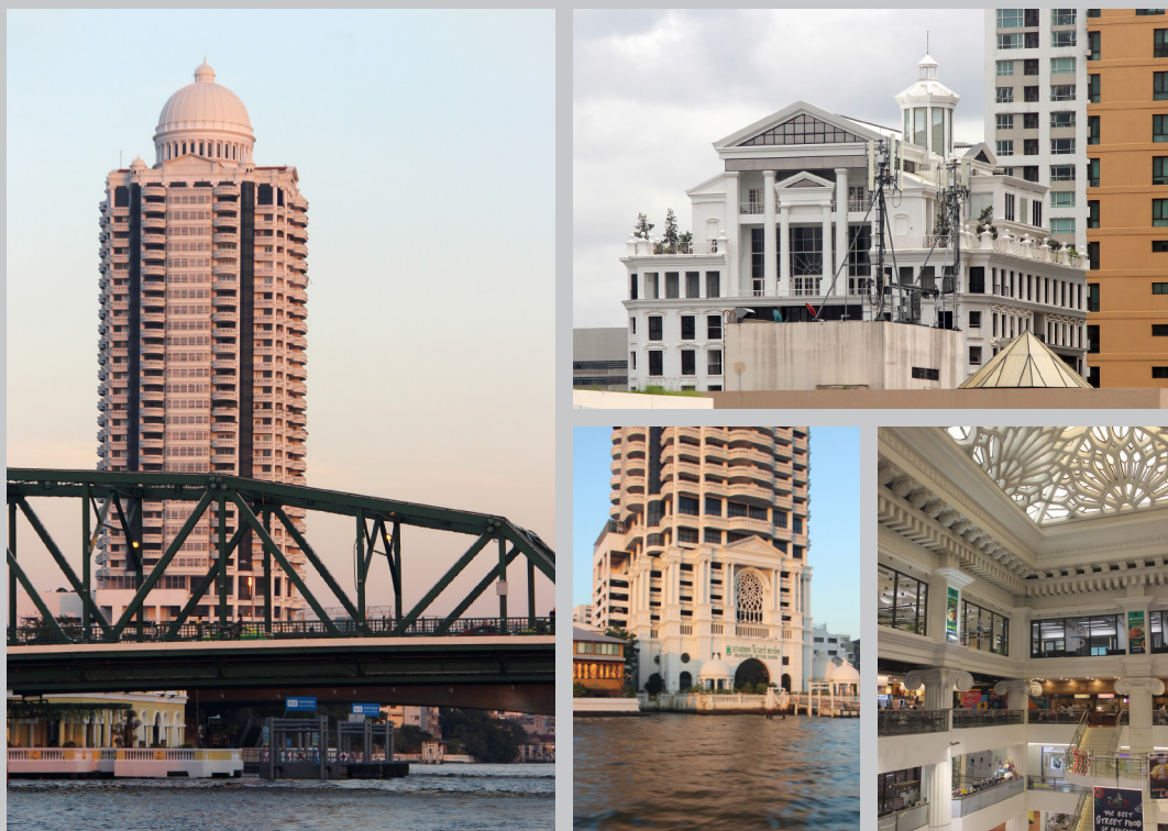
Fig. 01. Ejemplos de edificios postmodernos de estilo Luoi diseñados por el arquitecto Rangsam Torsuwan; a la izquierda: “River Park Condominium” (1994); arriba a la derecha: ático de “Royal Park” (1996); abajo a la derecha: atrio interior de “Amarin Plaza” (1985). Paco García Moro. “Bangkok Postmoderno”, Bangkok, 2019.
