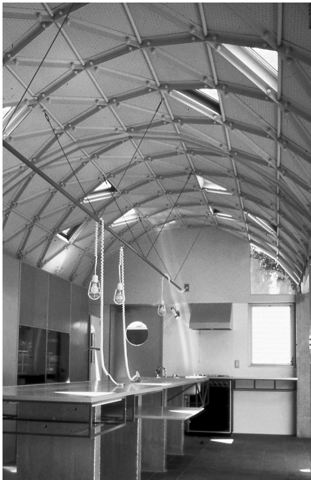
Fig. 03. Planta (arriba) y vista hacia la cocina (abajo). Toyo Ito. SilverHut. Tokio, Japón. 1984. © Cortesía de Toyo Ito & Associates, Architects.
