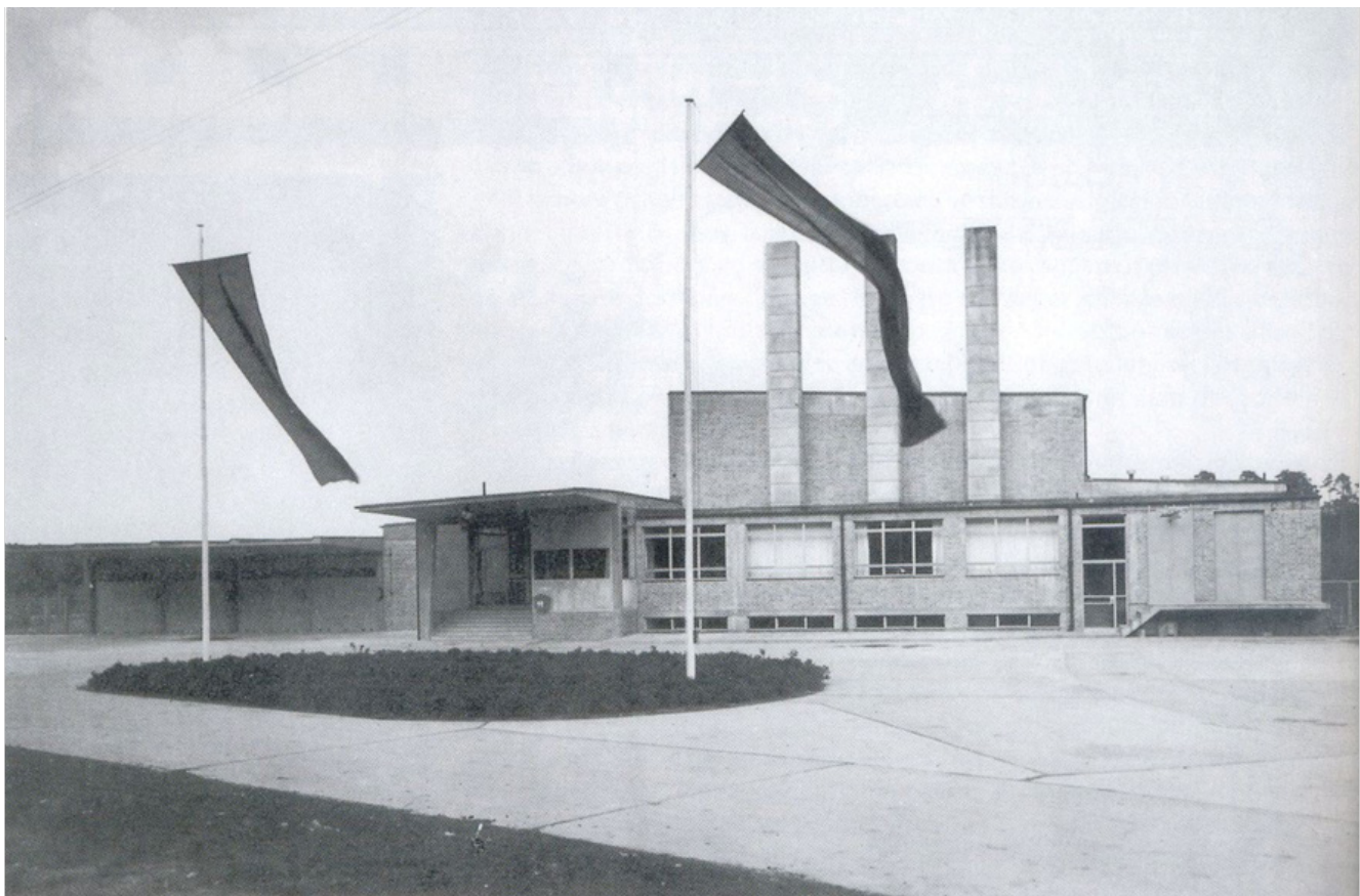
F.15. Escuela federal ADGB. Acceso principal.
