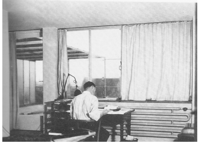
F.05 y F. 06. Haus Nolden. Construcción.
