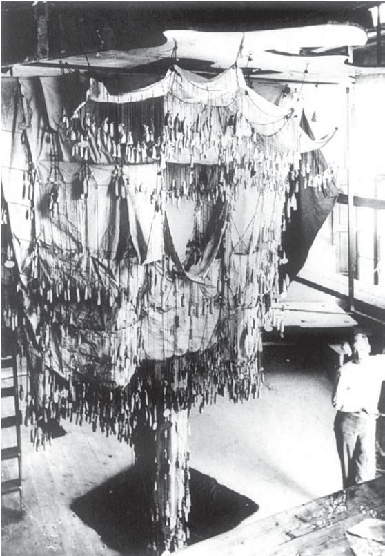
[F2] Antoni Gaudí. Maqueta funicular para la cripta de la Colonia Güell
