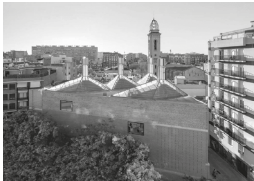
Fig. 10. FRAC Nord-Pas de Calais, Dunkerque, Francia, Lacaton & Vassal. Vista panorámica
