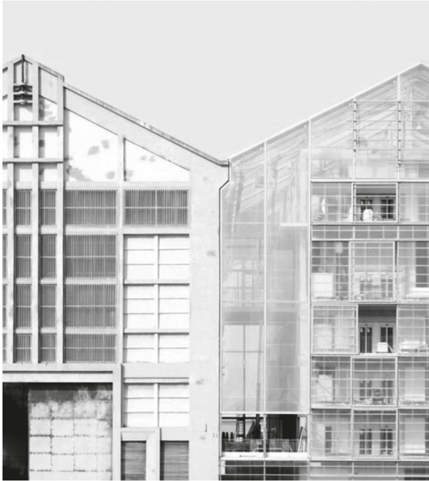
Fig. 06. FRAC Nord-Pas de Calais, Dunkerque, Francia, Lacaton & Vassal. Fachada Principal: Detalle del encuentro entre la preexistencia patrimonial y el cuerpo añadido contemporáneo
