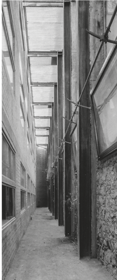
Fig. 08. FRAC Nord-Pas de Calais, Dunkerque, Francia, Lacaton & Vassal. Espacio intermedio entre la preexistencia patrimonial y el cuerpo añadido contemporáneo.
