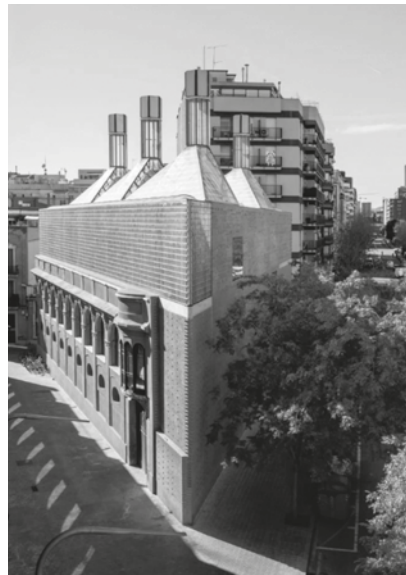
Fig. 03. Centre Civic Cristalerías Planell, Barcelona, España, HARquitectes. Vista general.
