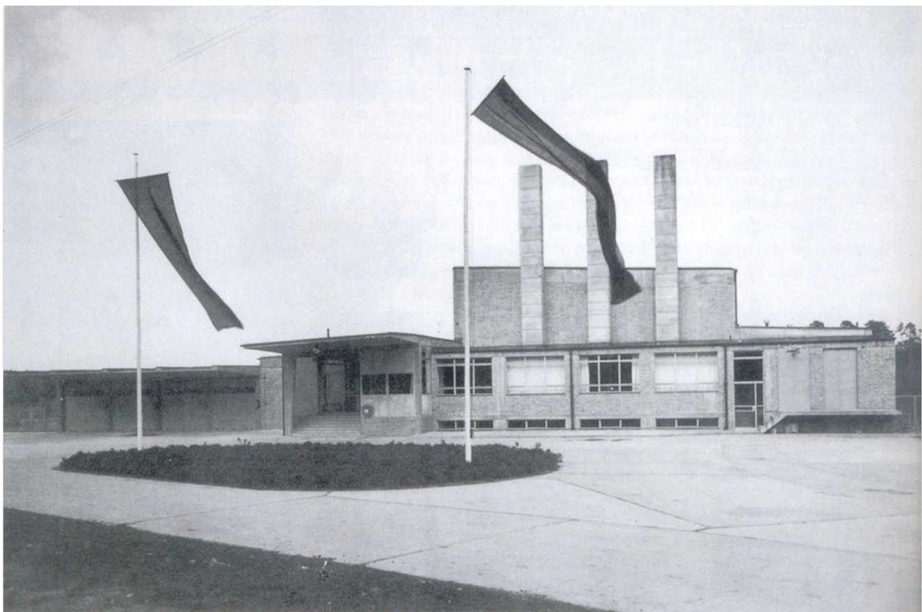
F.15. Escuela federal ADGB. Acceso principal.
