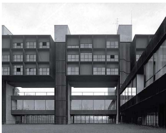
[F16] Centro de Instrucción IBM en Novedrate (Como, 1969-73). Los módulos de habitaciones sobre la plataforma de circulación y servicios comunes. Fotografía: Giorgio Casali.
