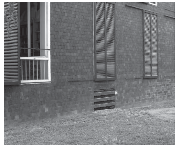
[F3] Encuentro del edificio con el suelo. © arroyopemjean.
