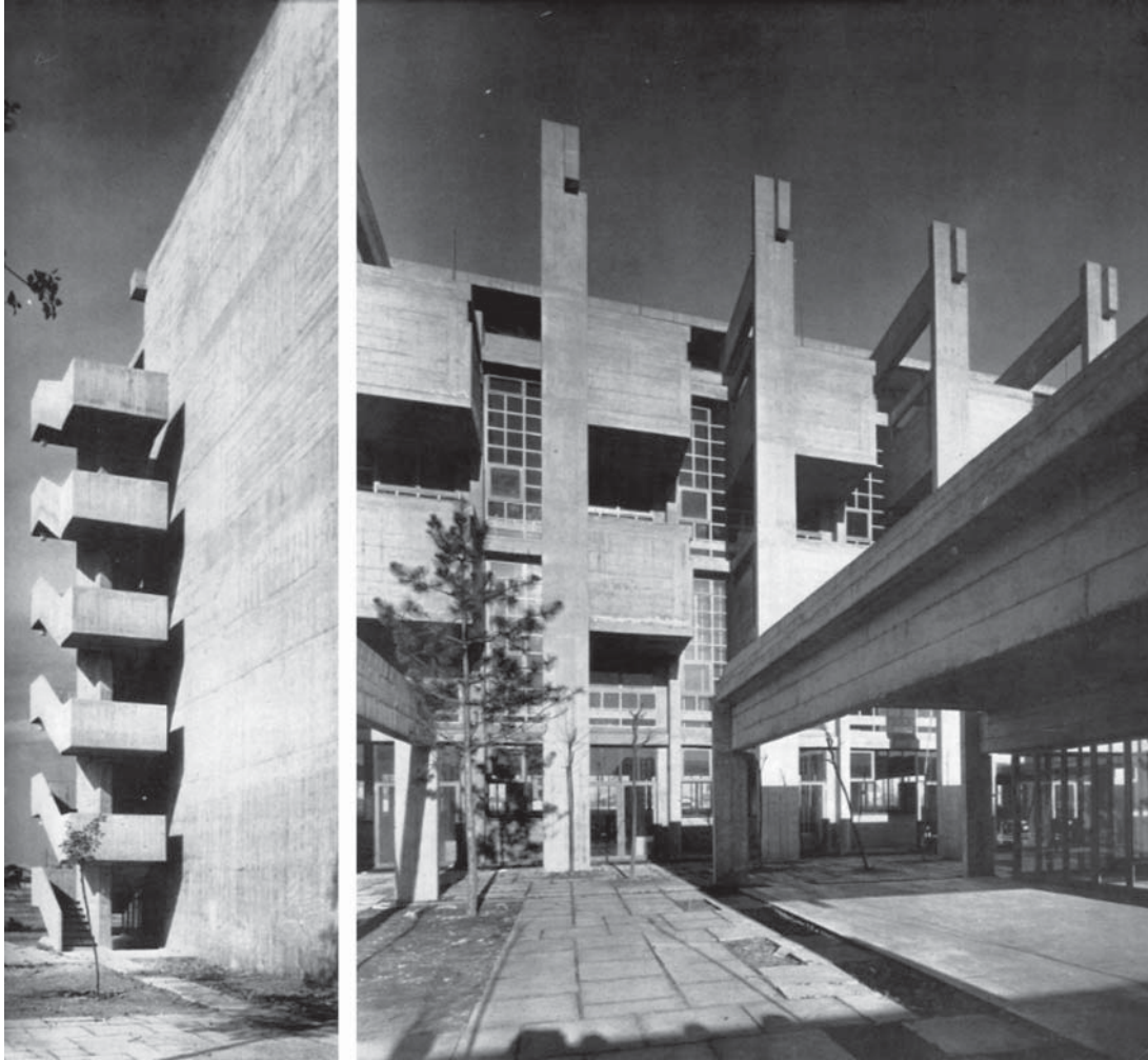
[F1] Vittoriano Viganò, Instituto Marchiondi (1957), fachada dormitorios. Archivo Vittoriano Viganò
