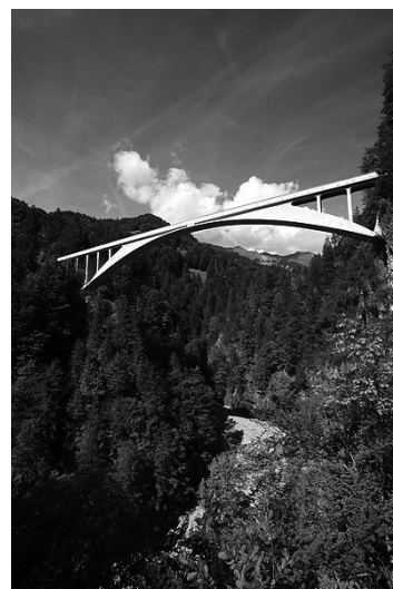
Fig. 2. Estructura de puente de Maillart. Francia
