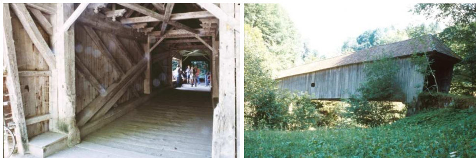
Figura 27: Puente Kubel próximo a St. Gall, Suiza, 1780; proyecto de Hans Grubenmann (© Jose L Fernandez Cabo).
