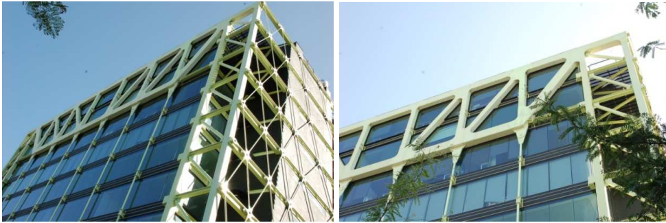
Figura 24: Media TIC, Barcelona. Arquitecto: Enric Ruiz Geli; Estructura: Agustí Obiols, BOMA, 2009 (© Jose L Fernandez Cabo).
