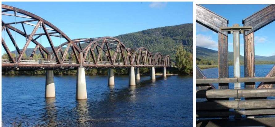
Figura 26: Puente en Evenstand, Noruega. Ingeniero: Otto Kleppe (© Jose L Fernandez Cabo).
