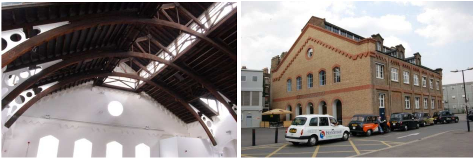
Figura 29: Cubierta del German Gymnasium, Londres, UK, 1864-65 (© Jose L Fernandez Cabo).
