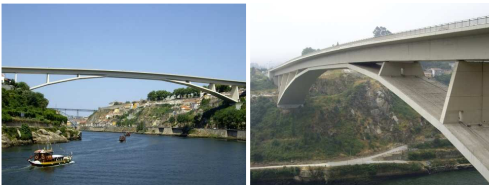
Figura 14: Puente del Infante D. Henrique, Oporto, Portugal. Ingeniería: IDEAM and Adão da Fonseca & Associados, SA. 1999 - 2002. (© Jose L Fernandez Cabo).
