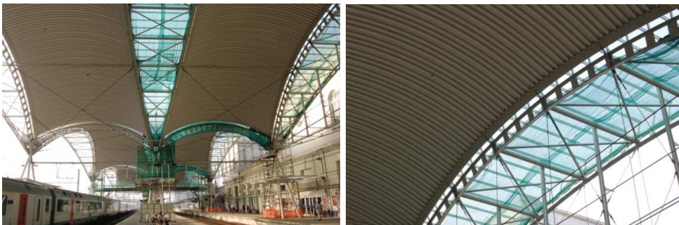
Figura 31: Cubierta de la estación de Leuven, Belgica (© Jose L Fernandez Cabo).
