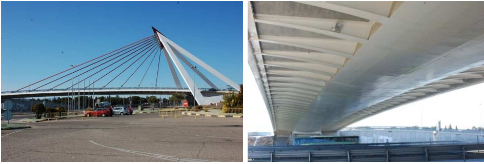
Figura 18: Puente sobre la autopista A-6 cerca de Las Rozas, Madrid, 107 m de luz, 2006. Ingenieros: Arenas y Asociados. (© Jose L Fernandez Cabo).
