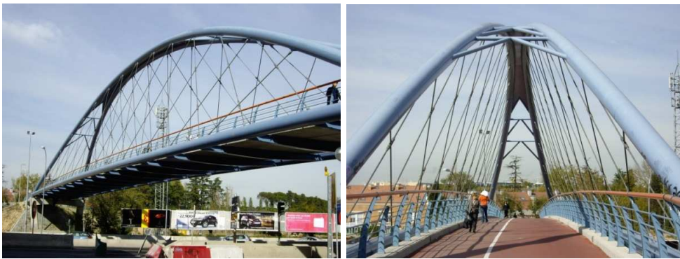
Figura 35: Arco con cables de la pasarela peatonal del Anillo Verde cerca de la fuente del berro, Madrid (© Jose L Fernandez Cabo).
