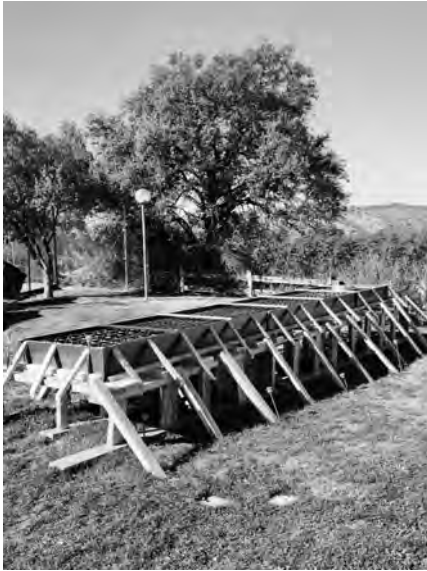
Fig. 9 Encofrado de madera.
