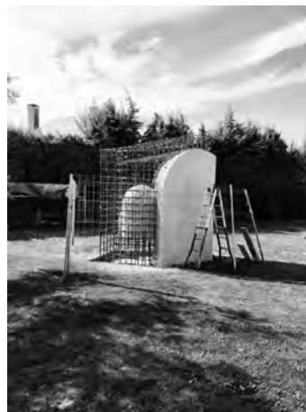
Fig. 5 Encofrado de poliestireno y armado interior.
