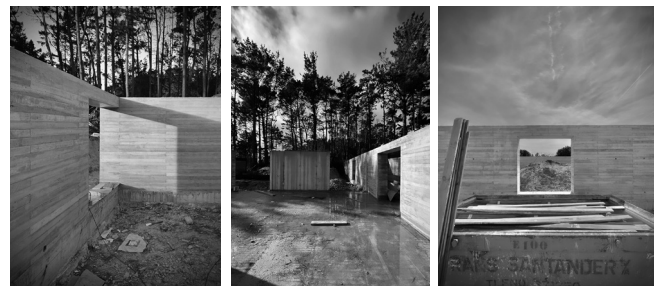
Figs. 11, 12 y 13 Muros en construcción.
