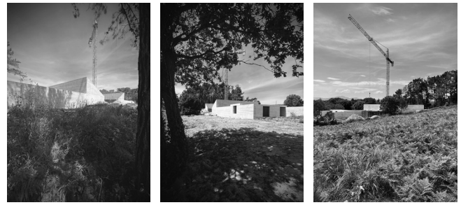
Figs. 8, 9 y 10 La casa en construcción.
