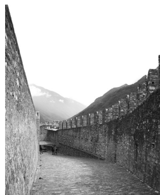
Fig. 10 Rampa de acceso. Al fondo salida del ascensor. Bellinzona 2023. Fotografía del autor.
