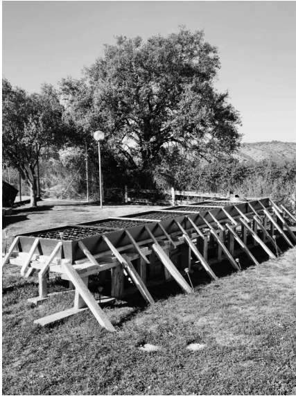
Fig. 9 Encófrado de madera.
