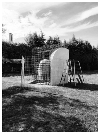
Fig. 5 Encofrado de poliestireno y armado interior.
