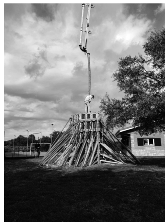
Fig. 6 Durante el hormigonado. Vista del encofrado de madera exterior.
