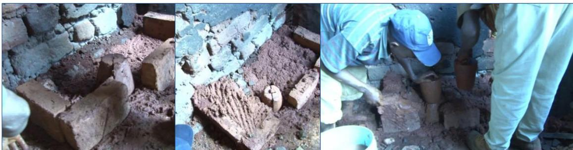
Figura 4. Detalle de las fases iniciales de la construcción: Colocación del perímetro de ladrillos de arcilla y mediciones de la ubicación los moldes de madera (izq.), relleno con capas alternas de grava gruesa y arcilla (dcha.) y colocación de los moldes. Fuente: TFCG.
