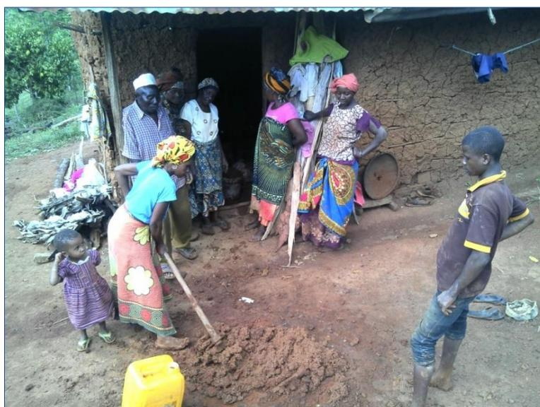
Figura 9. Una CBT prepara el material para construir la cocina a partir de agua y la tierra arcillosa presente en las inmediaciones de las viviendas del proyecto.
