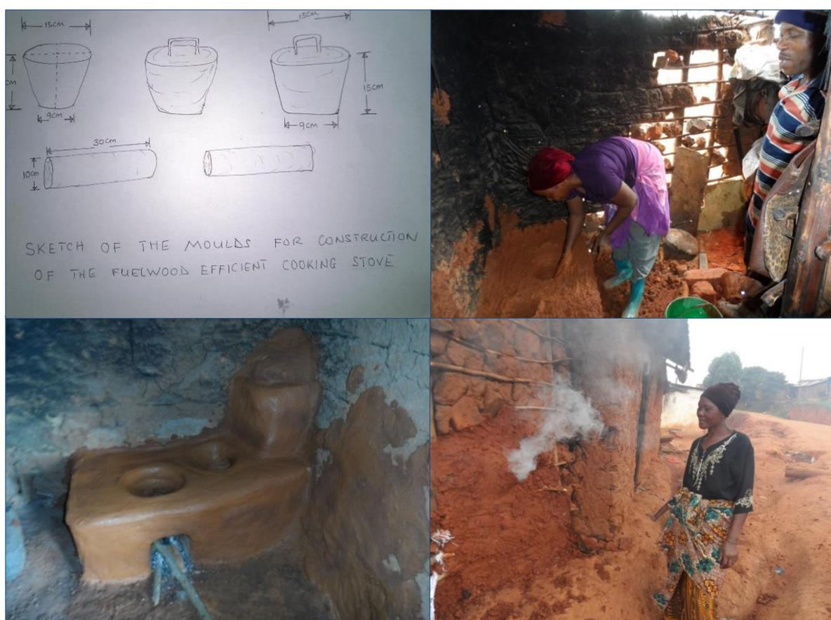
Figura 5. Cocina Mejorada. Croquis de moldes (A). Mujer construyendo la cocina (B). Cocina terminada (C). Chimenea (D). Fuente: TFCG
