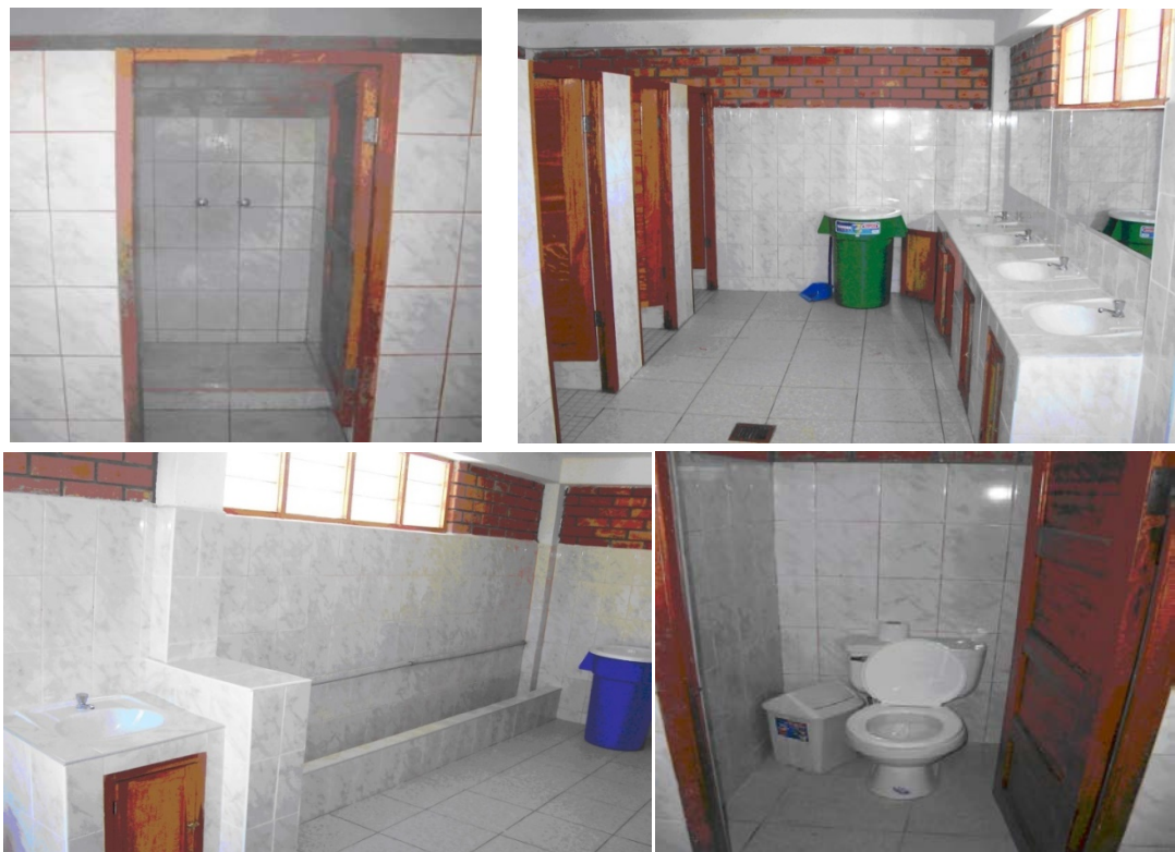
Figura 4. Estado final del interior de las instalaciones. Fuente: JA, Mancebo.
