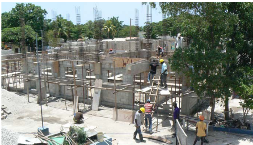
Figura 4. Ejecución de estructura de colegio en Haití. Año 2010. Fuente: Miren Escartín.
