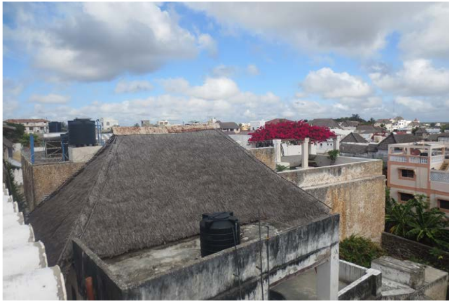
Figura 4. Varios depósitos en azoteas.
