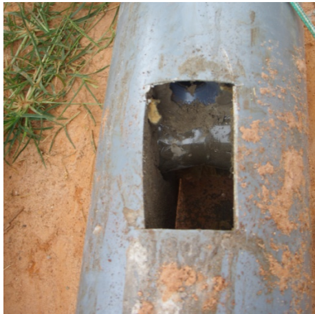
Figura 20. Tubería macizada inferior con polea inferior.
