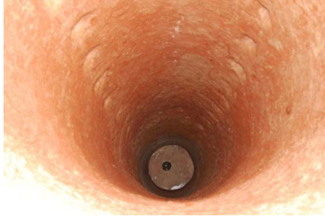
Figura 7. Excavación de uno de los pozos con la losa intermedia.
