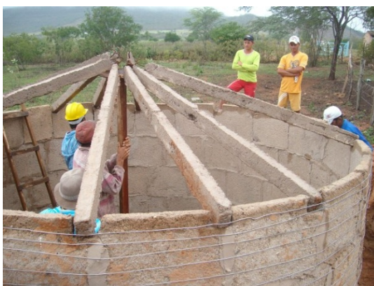
Figura 9. Pared y vigas de cubierta.
