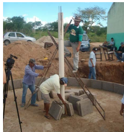
Figura 10. Construcción del pilar.
