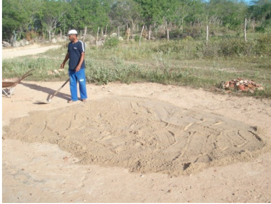
Figura 5. Preparación para prefabricación.
