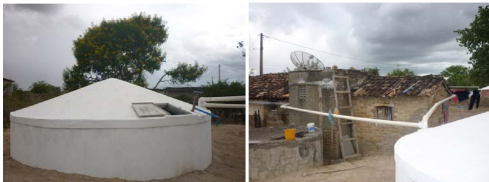
Figuras 1 e 2. Cisterna de placas (Esq), e Sistema de Captação de água de chuva que cai nos telhados (Dir.) Fonte: Arquivo próprio (2011)
