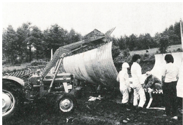
Figura 6. Agricultores de la zona ayudan en la construcción de la Casa del Pionero (Ishiyama 1984).
