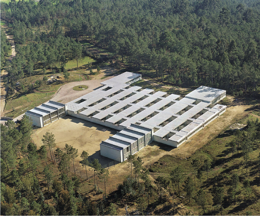
Figura 22. Vista del Colegio Saladino Cortizo de Desiderio Pernas. Fuente: Registro Docomomo Ibérico.
