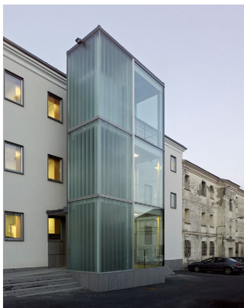
Figura 11. Fachada con bloque reformado y bloque original de la casa cuartel de Ferrol (A Coruña). Autor: Héctor Santos-Díez, 2018.
