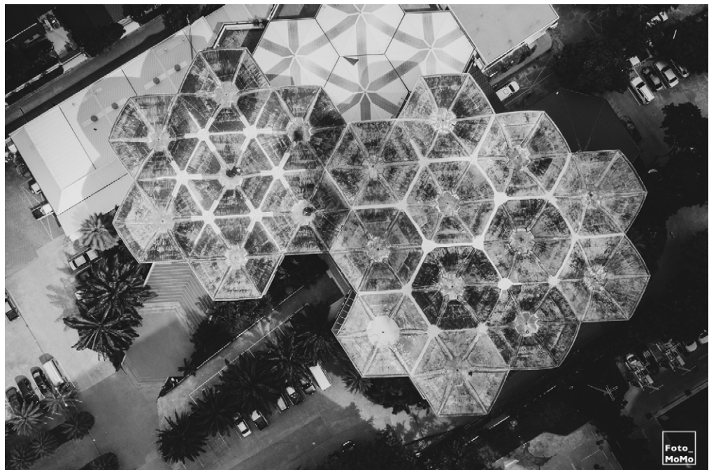
Figura 11. Vista de dron de la azotea de la Fundación del Centro Islámico por Paichit Pongpuluk (1971-81). Crédito: Beer Singnoi.
