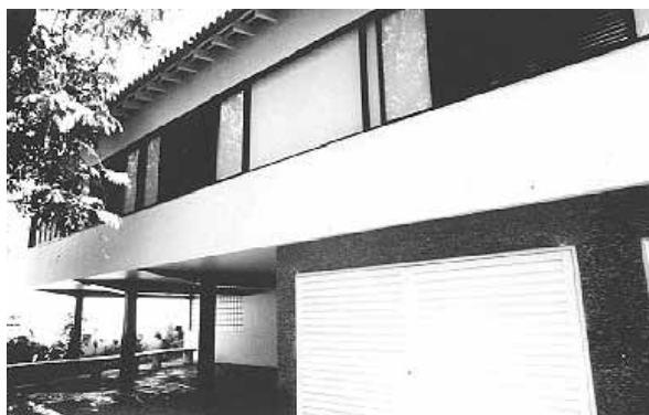
4. Residencia Francisco Ignácio Peixoto, fachada principal, Oscar Niemeyer, 1940-41, Cataguases, MG.
