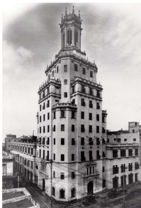
Sede de la Cuban Telephone Company en La Habana.
