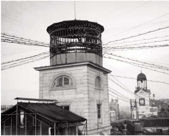
Izquierda. Cableado aéreo en el templete de la central de la calle Mayor, poco antes de su desmontaje, 1927.
