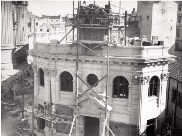
Izquierda. Construcción de la central telefónica de Málaga, 1928.
